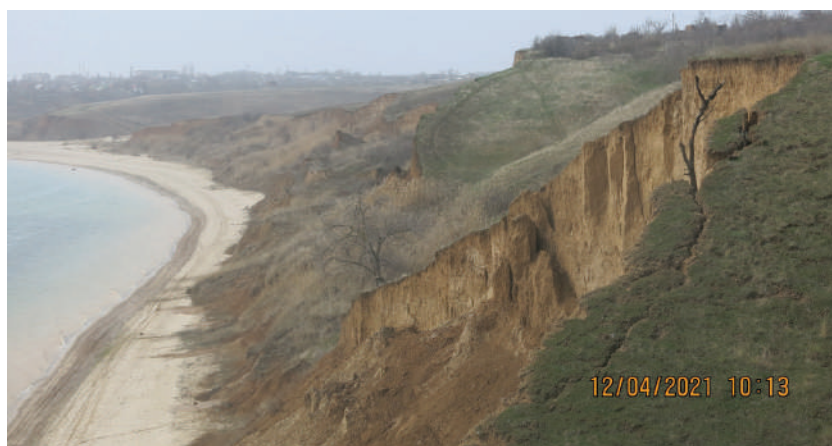
Фото 8. Обрушение коренного берега в границах садоводческого товарищества «Винзавод» г. Цимлянска Ростовской области
