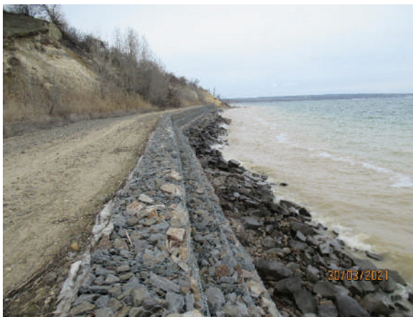
Фото 19, 20. Берегоукрепление Цимлянского водохранилища в черте г. Цимлянска и у х. Крутого Цимлянского района Ростовской области
