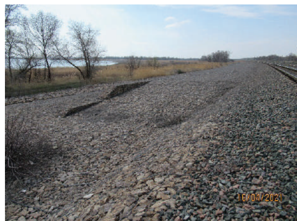
Фото 17. Берегоукрепление Цимлянского водохранилища в районе х. Рычковского Суворовкинского района ВО
