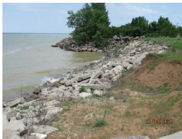
Фото 15. Берегозащитное сооружение в х.Харсееве Дубовского района РО
