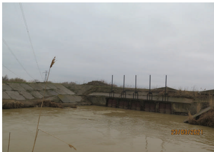
Фото 1. Водопропускное сооружение между западным и восточным отсеками.
