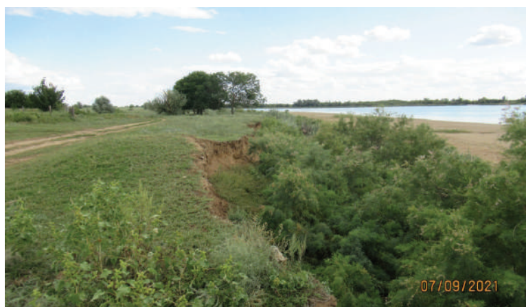
Фото 4. Обрушение коренного берега в х. Красноярском Котельниковского района Волгоградской области
