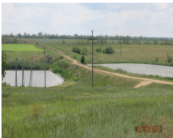
Фото 14. ГТС на балке Котлубань Ст. Калининская Цимлянского района РО
